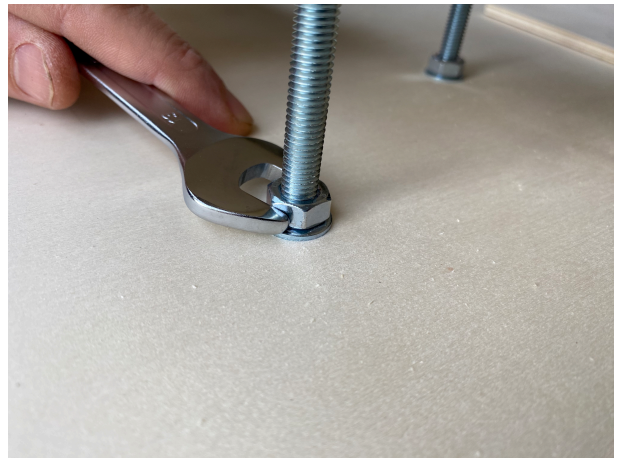
Foto 2. Fissaggio del dado nella parte superiore.
