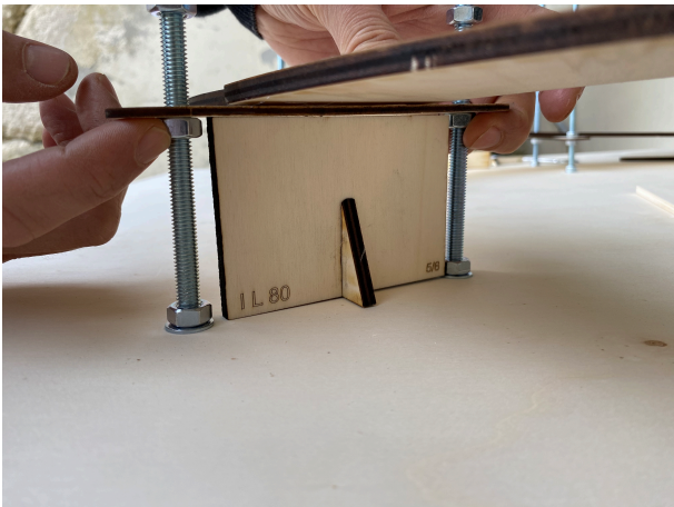
Foto 3. Utilizzo di un distanziatore (opzionale) per determinare l'altezza del primo giro.
