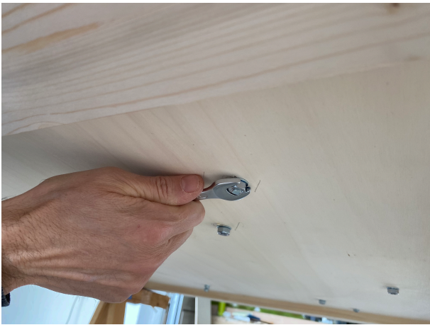
Foto 1. Fissaggio del dado nella parte inferiore.
