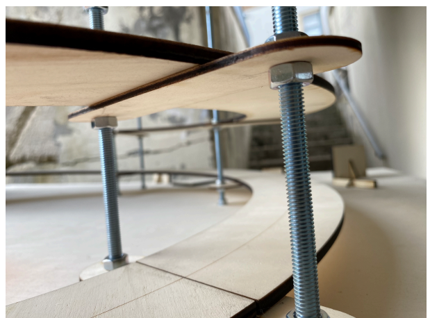
Foto 6. Fissaggio del dado nella parte inferiore.
